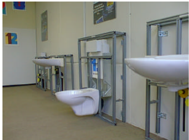
Abb. 1: Vorwandinstallation in einem GLA-Fachraum
