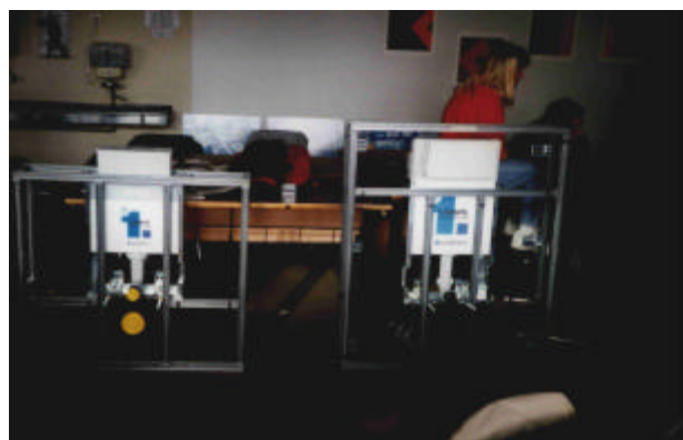
Abb. 4: Tragsystem mit sanitären Montageelementen
