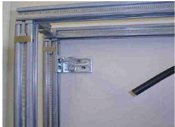
Abb. 3: Profil, Profilverbinder, Verbindungsstück und Montagewinkel des Installationssystems
