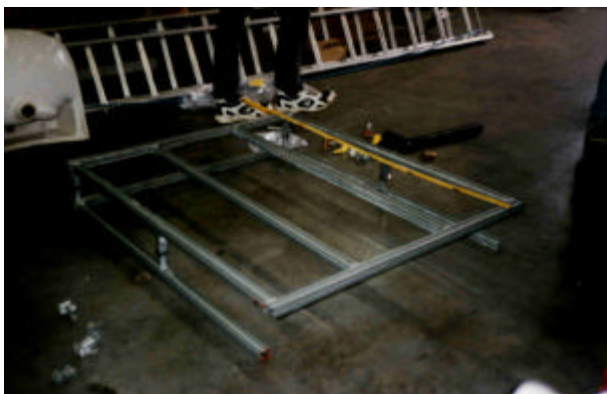
Abb. 2: Herstellung/Montage des Tragsystems
