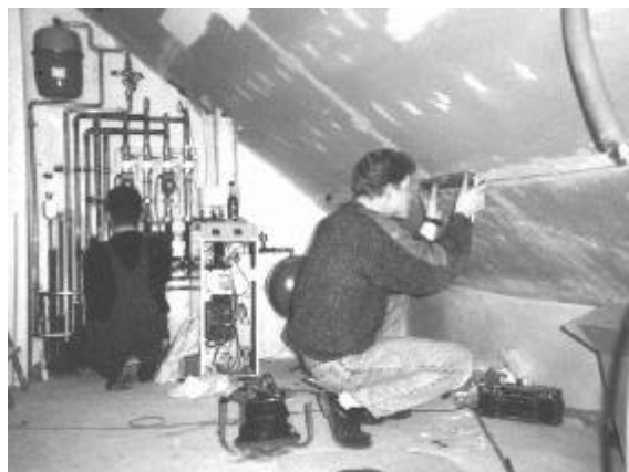
Abbildung: Die Inneninstallation kommt gut voran
